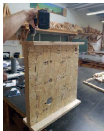
Erstellung der Bohrungen (Maße siehe nächste Seite)
