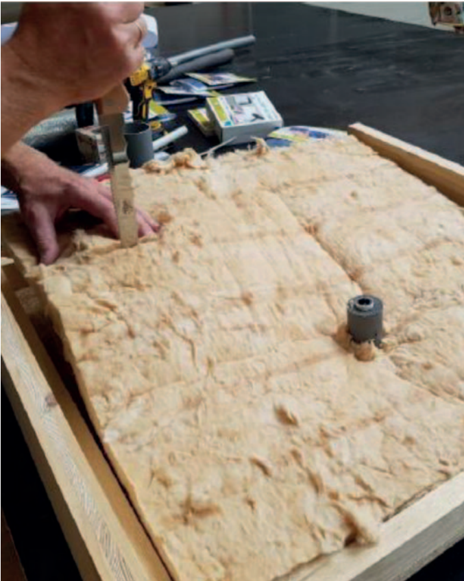
Einlegen der Wärmedämmmatte ( D = 50 \text{ mm} ) und Ausschnitt der Durchdringungen
