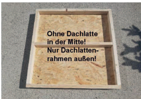
Dachlatten (24/48) umlaufend aufschrauben
