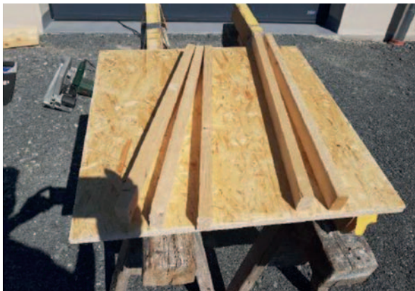
Zuschneiden OSB und Dachlatten
